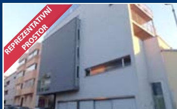
KANCELÁŘE V CENTRU BRNA • pronájem kancelářské jednotky na ul. Pellicova • celková výměra 28 m 2 • cihlová budova po rekonstrukci N/RSB/12514/13 14 000 Kč/měs. + en. a sl.
