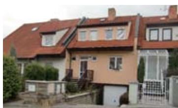
RODINNÝ DŮM, BRNO - LIŠEŇ • podsklepený řadový RD 4+kk • garáž, předzahrádka, zahrada • venkovní bazén • výborný technický stav N/RSB/11007/12 6 500 000 Kč
