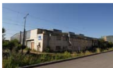
VÝROBNÍ HALA, KUŘIM • prodej haly, 6x jeřáb, výška 10m • hala 6 900 m 2 • adm. a zázemí 3 300 m 2 • pozemek 14 200 m 2 N/RSB/9404/11 19 900 000 Kč
