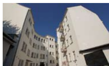
SOUBOR NEMOVITOSTÍ, BRNO - STŘED • prodej adm. budova 2 474 m 2 • nájem. dům 1 155 m 2 • adm. sklad, výroba 587 m 2 - pozemek 1 809 m 2 N/RSB/11524/13 65 000 000 Kč
