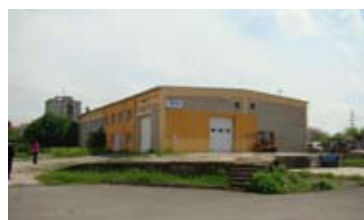
HALA, BRNO - MĚSTO • pronájem skladové haly s kancel. a soc. zázemím • užitná pl. 570 m 2 , venkovní zpevněná plocha 2 700 m 2 N/RSB/10575/12 70 000 Kč/měs.
