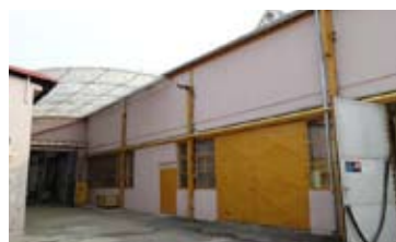
KOMERČNÍ OBJEKT, BRNO - TRNITÁ • prodej polyfunkčního areálu • sklady/výroba 1 080 m 2 , kanceláře 415 m 2 • pozemek celkem 1 800 m 2 N/RSB/10781/12 19 500 000 Kč
