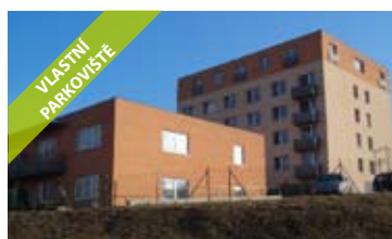
NÁJEMNÍ DŮM, BRNO - LÍŠEŇ • prodej 2 nájemních domů • zrekonstruovaný dům s 25-ti byty, novostavba ND s 8 byty • užitná pl. 2 130 m 2 N/RSB/9939/12 53 000 000 Kč
