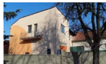
AREÁL, BRNO - CHRŮVICE • prodej admin. budovy se skladem v blízkosti dálnice D2 • UP 322 m 2 (sklady 126 m 2 , admin. a zázemí 196 m 2 ) N/RSB/10060/12 6 800 000 Kč
